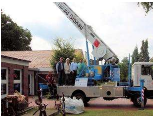
Die Petrusgemeinde bekommt ein neues Kirchendach. Foto: Dübbel
